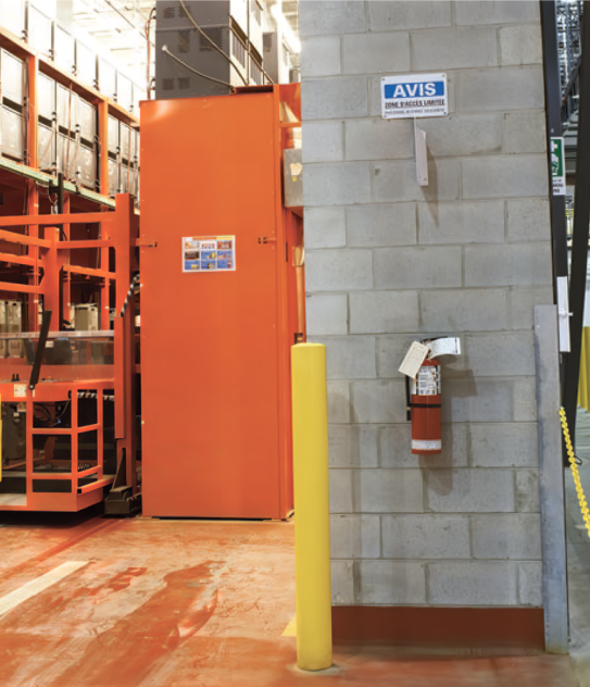
L'extincteur est obligatoire Photo : André Caty
